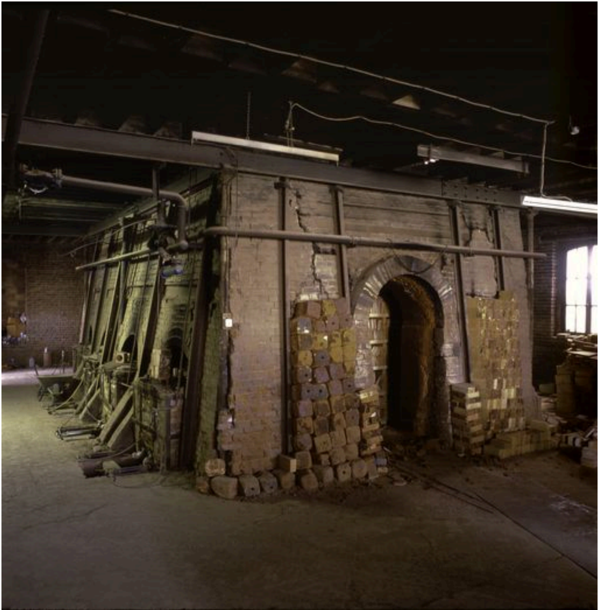
Vue d'ensemble du four de cuisson, dit four n°4.
