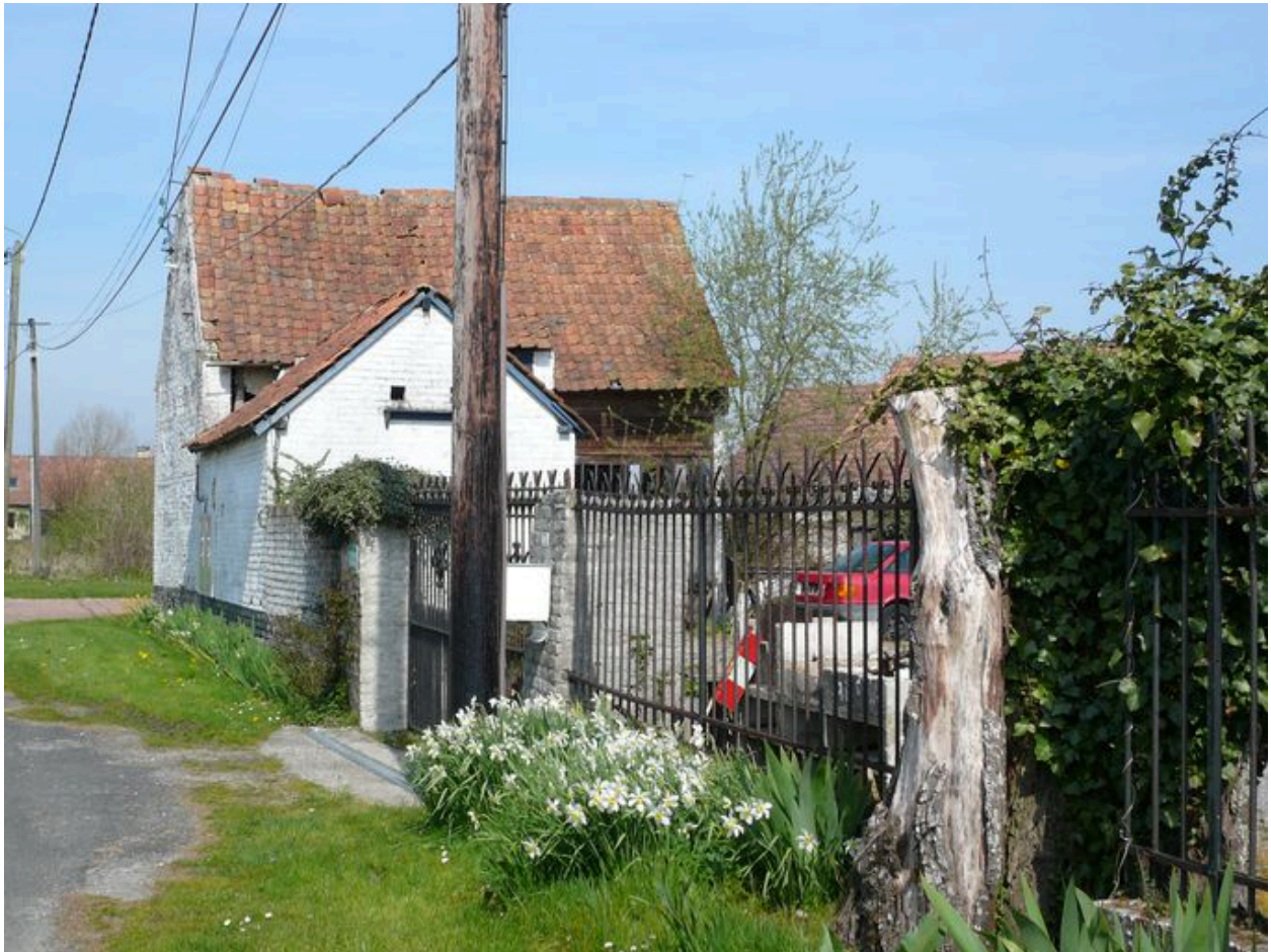
Vue du grenier, du pigeonier et des porcheries sur rue.
