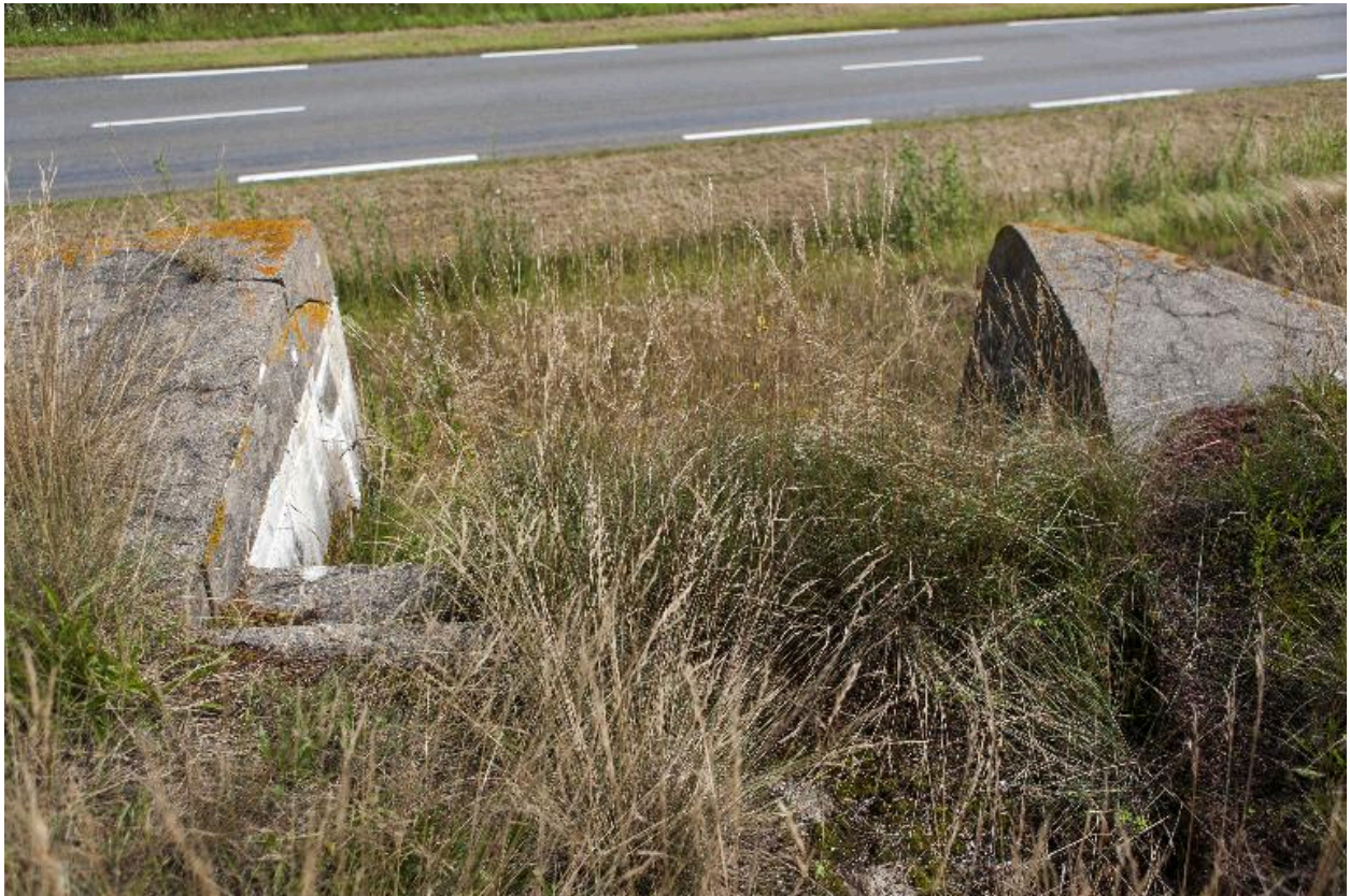
Banquette de tir depuis le couvrement, vers lest
