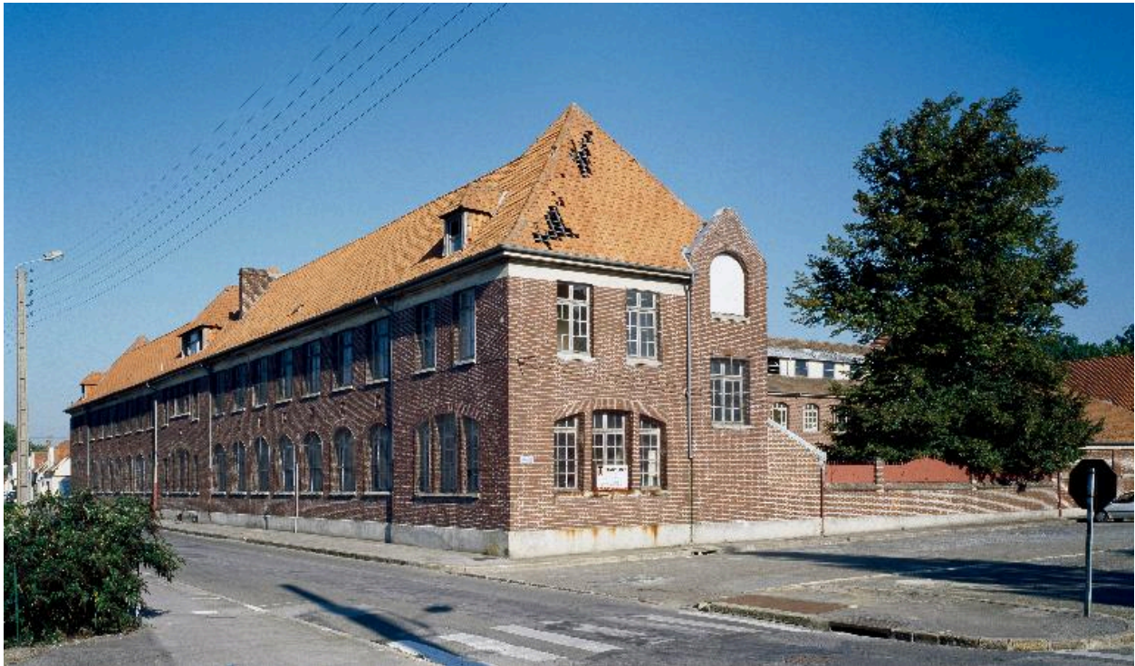
Vue des façades à l'angle des rues Victor-Hugo et Georges-Clémenceau.
