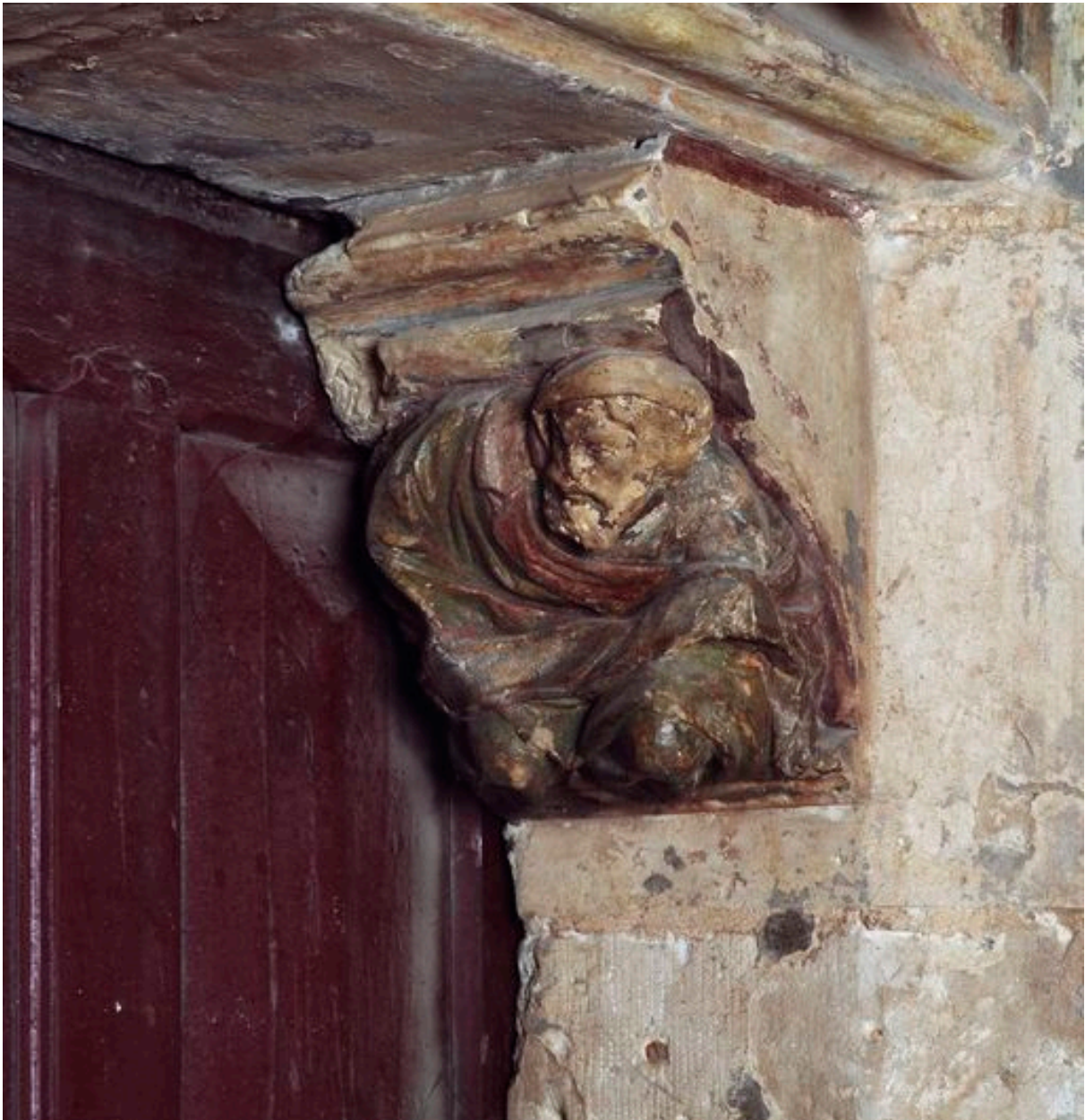
Décor du corbeau droit, après restauration.
