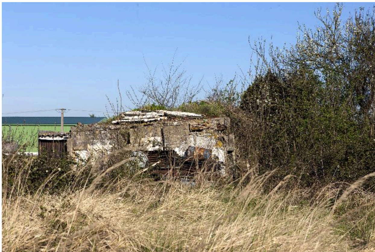
Casemate A, vers le nord
