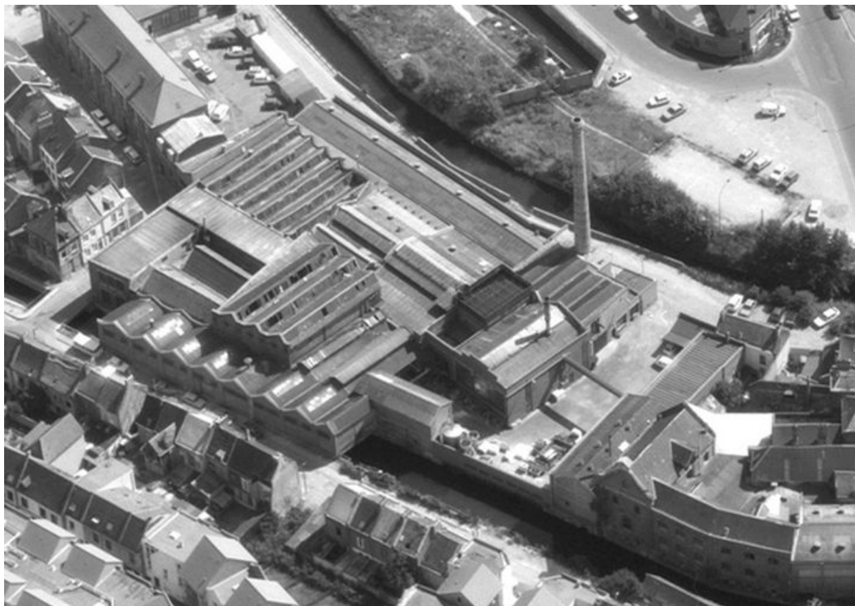
Vue aérienne, flanc nord-ouest.
