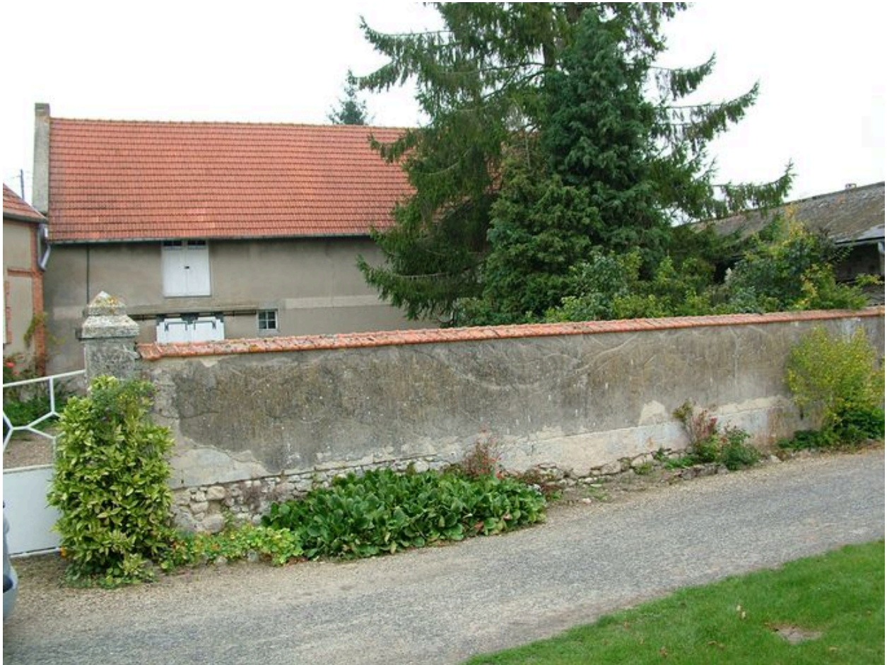
Vue du bâtiment agricole.
