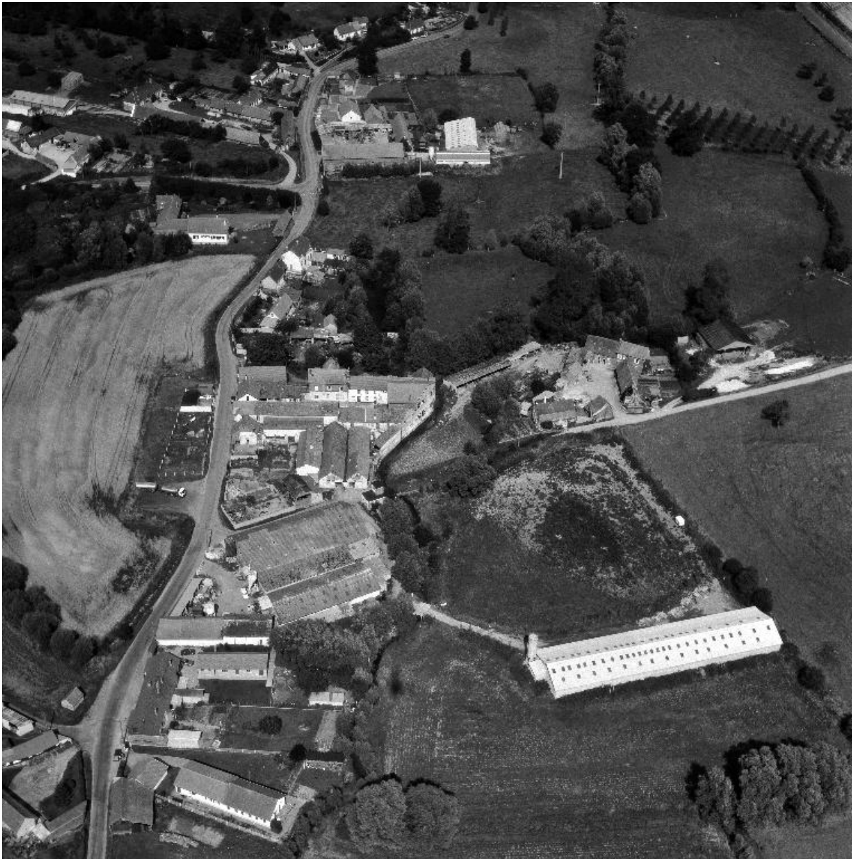
Vue aérienne, flanc sud-ouest.
