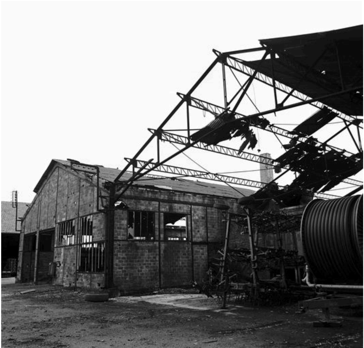
Atelier de fabrication, flanc est.
