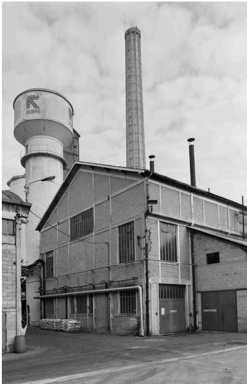
Chaufferie, château d'eau.
