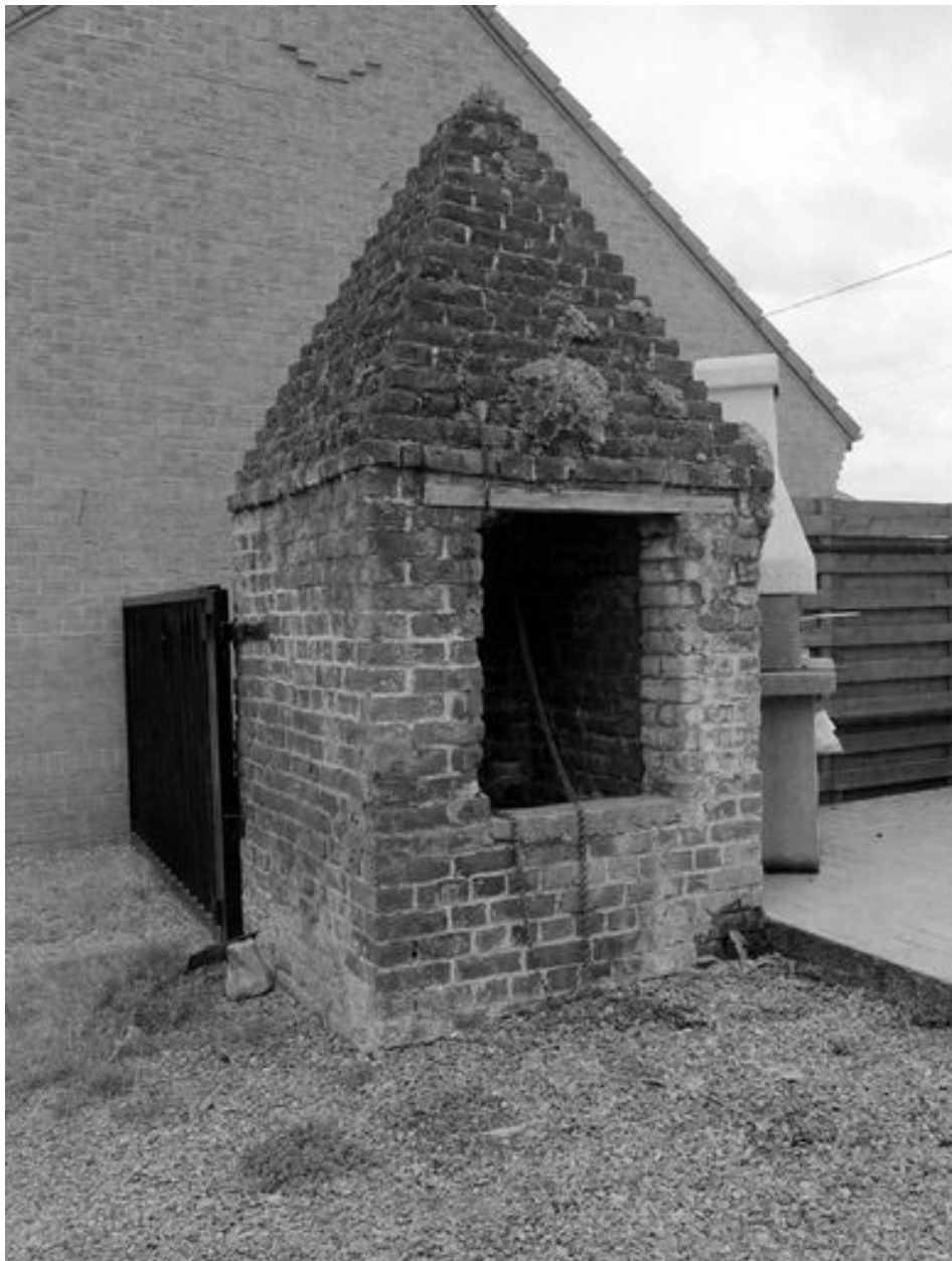
Vue générale du puits G.
