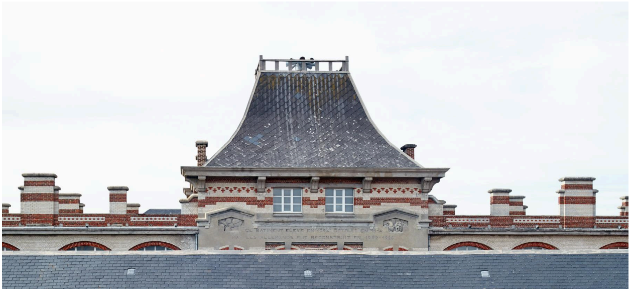
Toiture et partie supérieure du pavillon central, portant une inscription.
