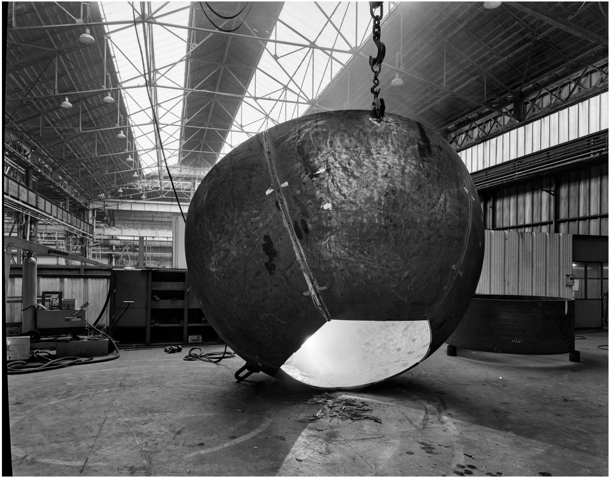
Hall 11 : le montage des segments, le soudage.
