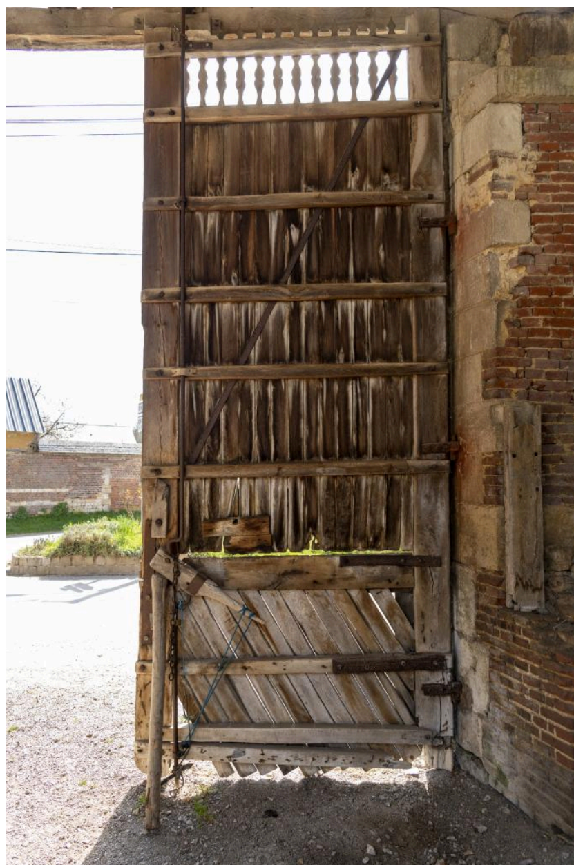
Détail d'un battant de porte depuis l'intérieur, n°3 rue Principale.
