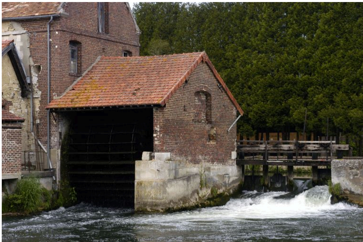
Vue d'ensemble de la roue hydraulique dans sa cage.
