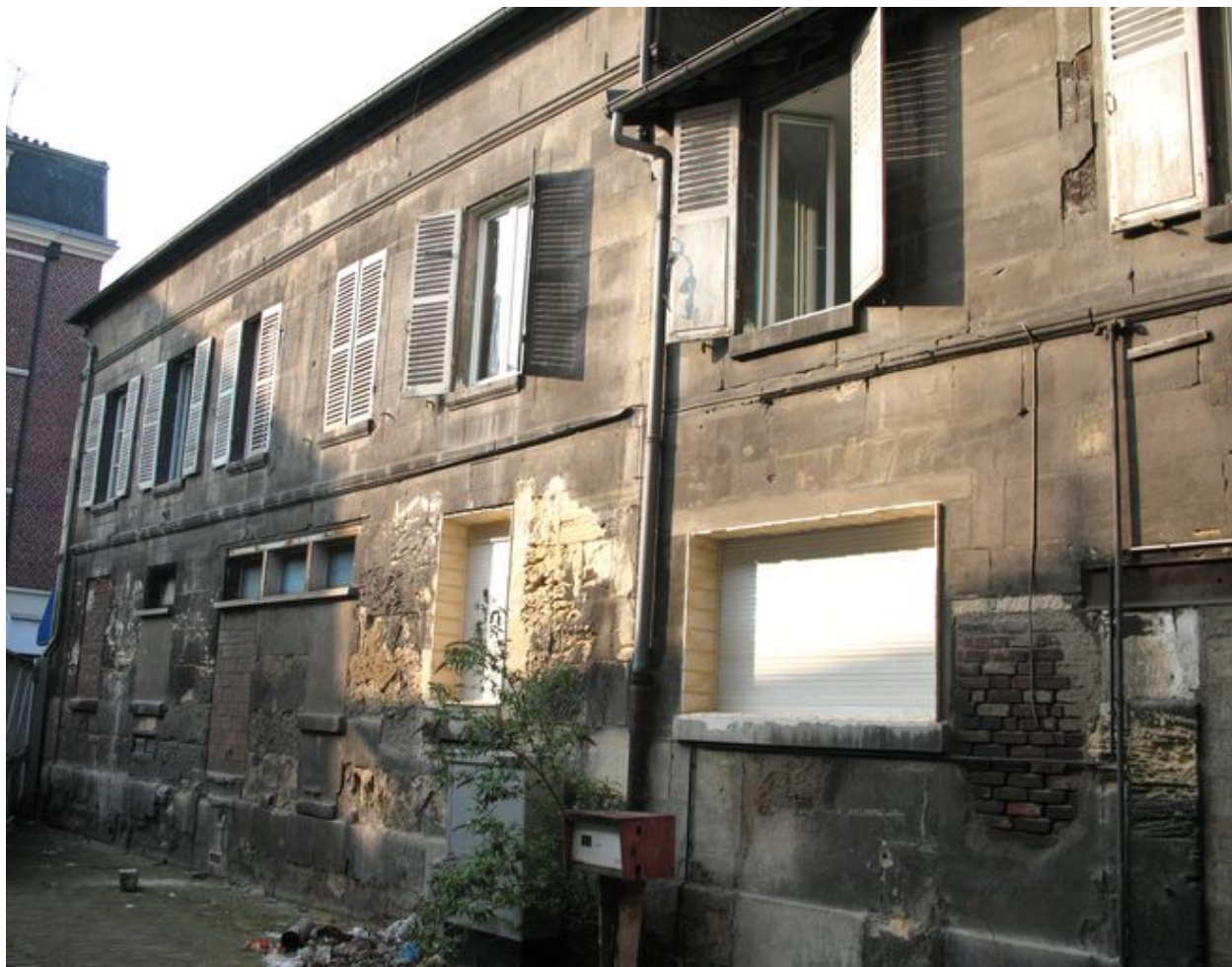
Vue des logements construits face aux bureaux.
