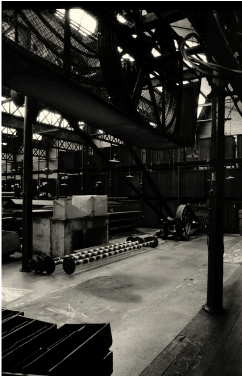
Détail des transmissions, 1988.
