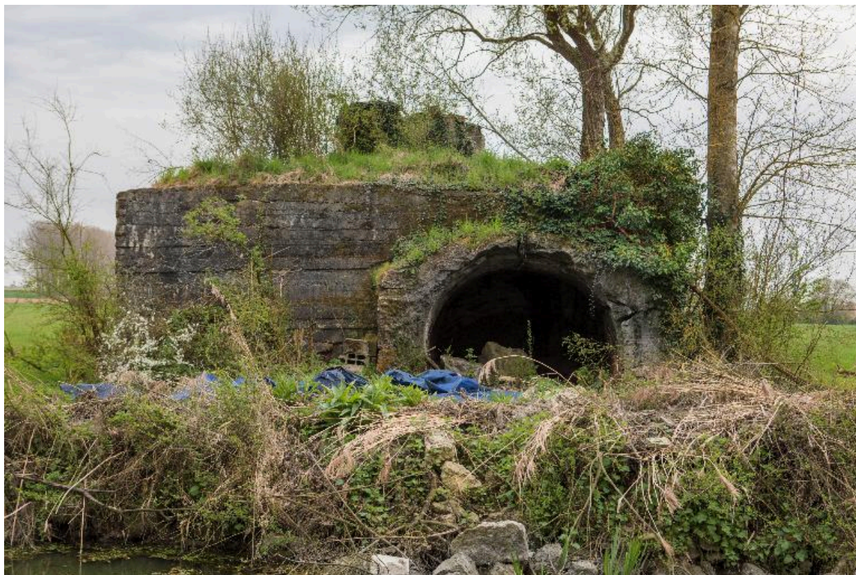
Edifice b, vers le sud
