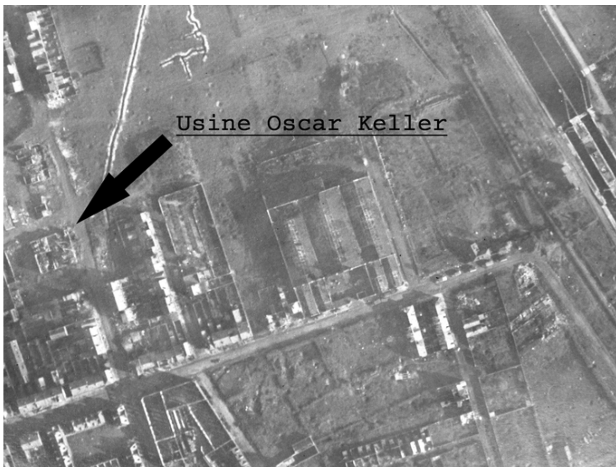
Vue aérienne de l'usine en novembre 1918, après destruction (AD Aisne).
