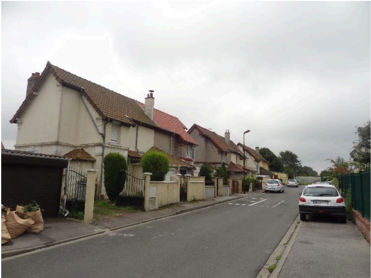
Immeuble à logements locatifs rue Sainte-Cécile : vue générale.
