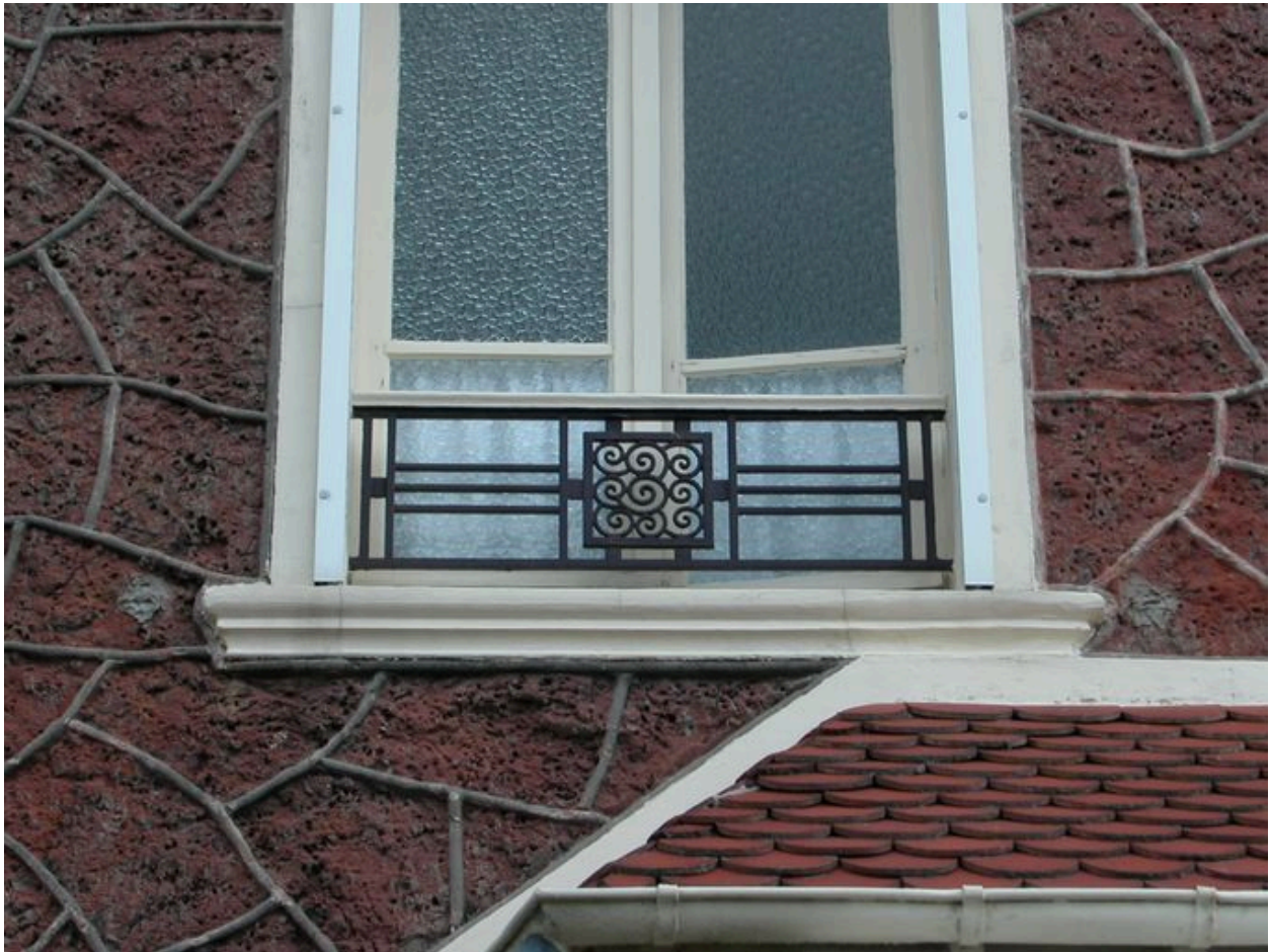
Détail du décor de fonderie des garde-corps.
