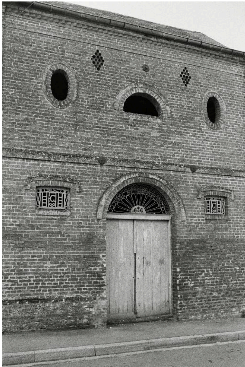
Vue de la façade sur rue de l'ancien entrepôt Grandsire (1880), en 1990.
