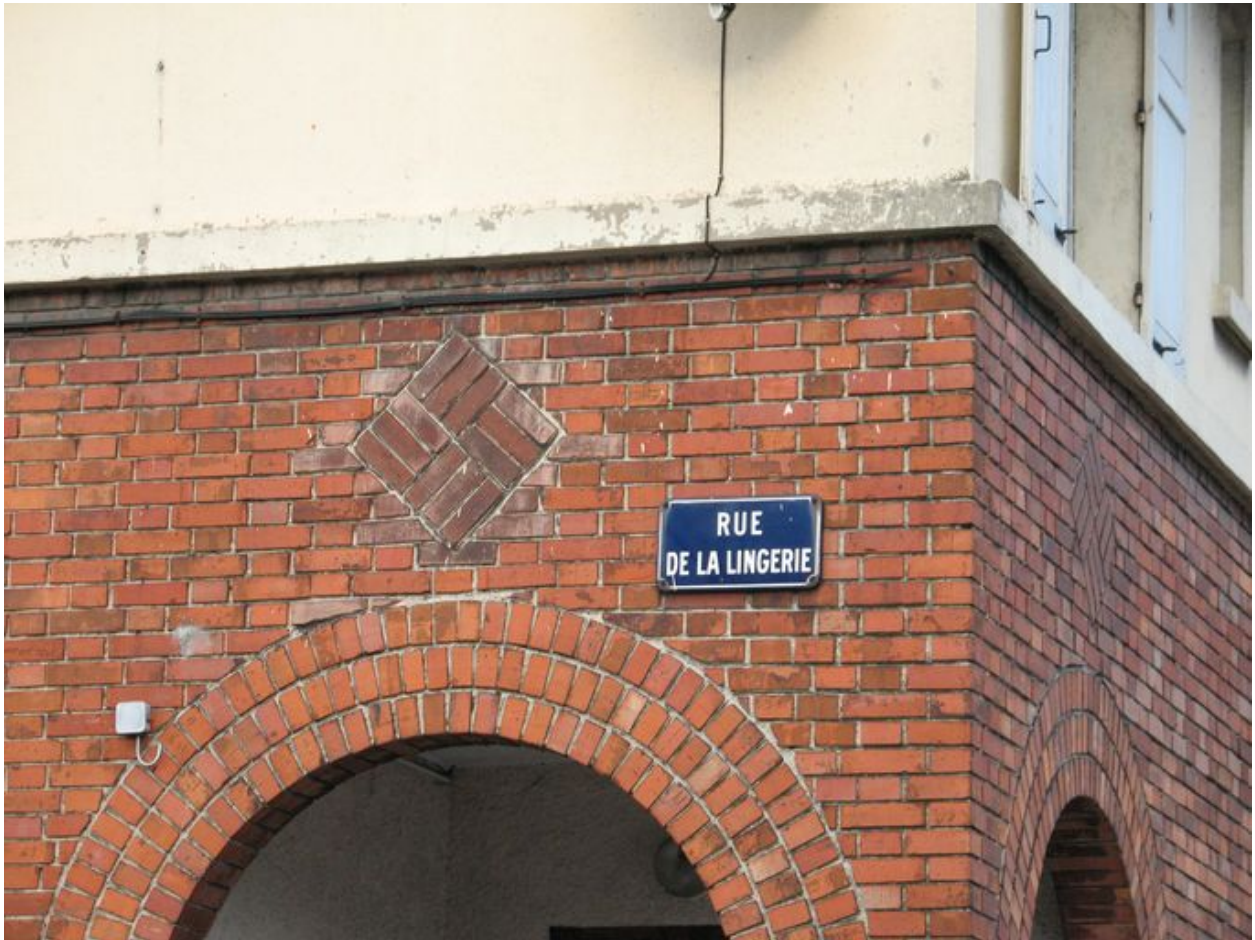
Détail de la mise en oeuvre des briques.
