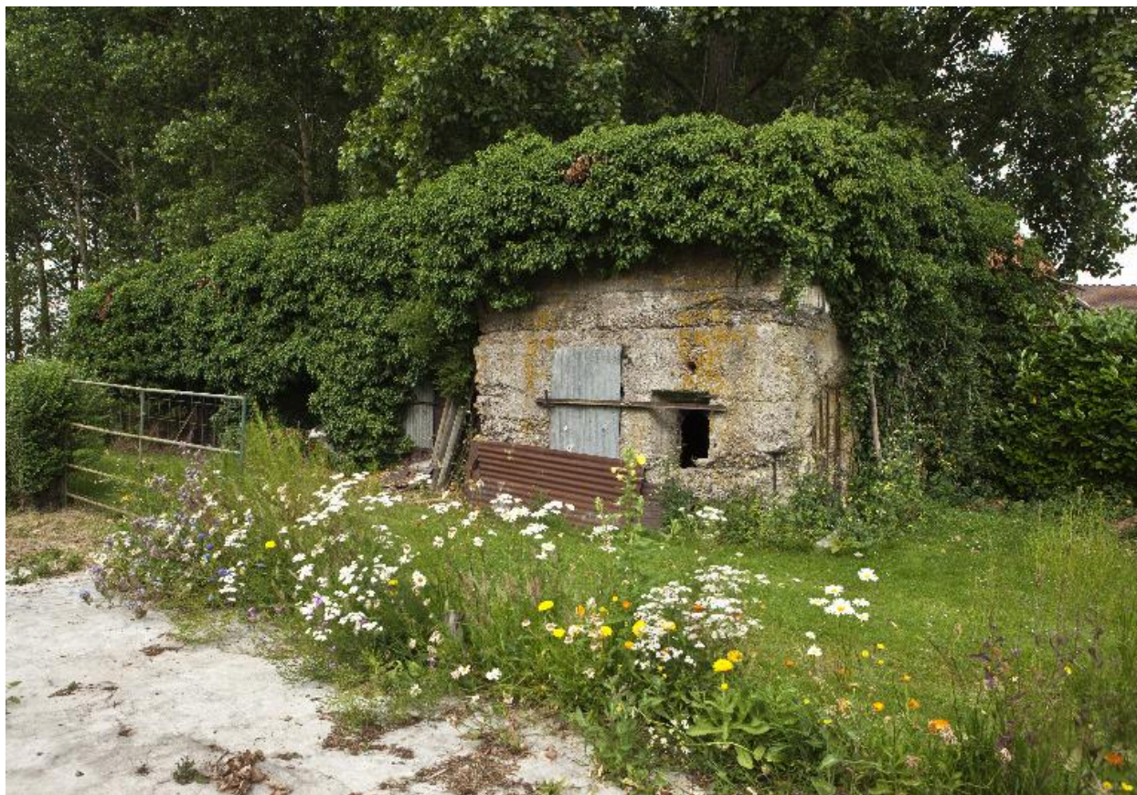
Entrée et fenêtre sur l'élévation sud-est
