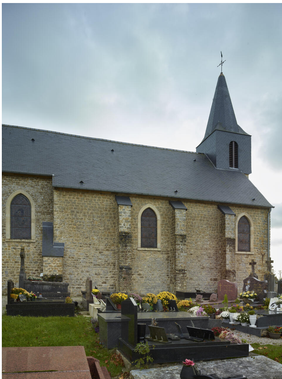
Vue de l'élévation nord.
