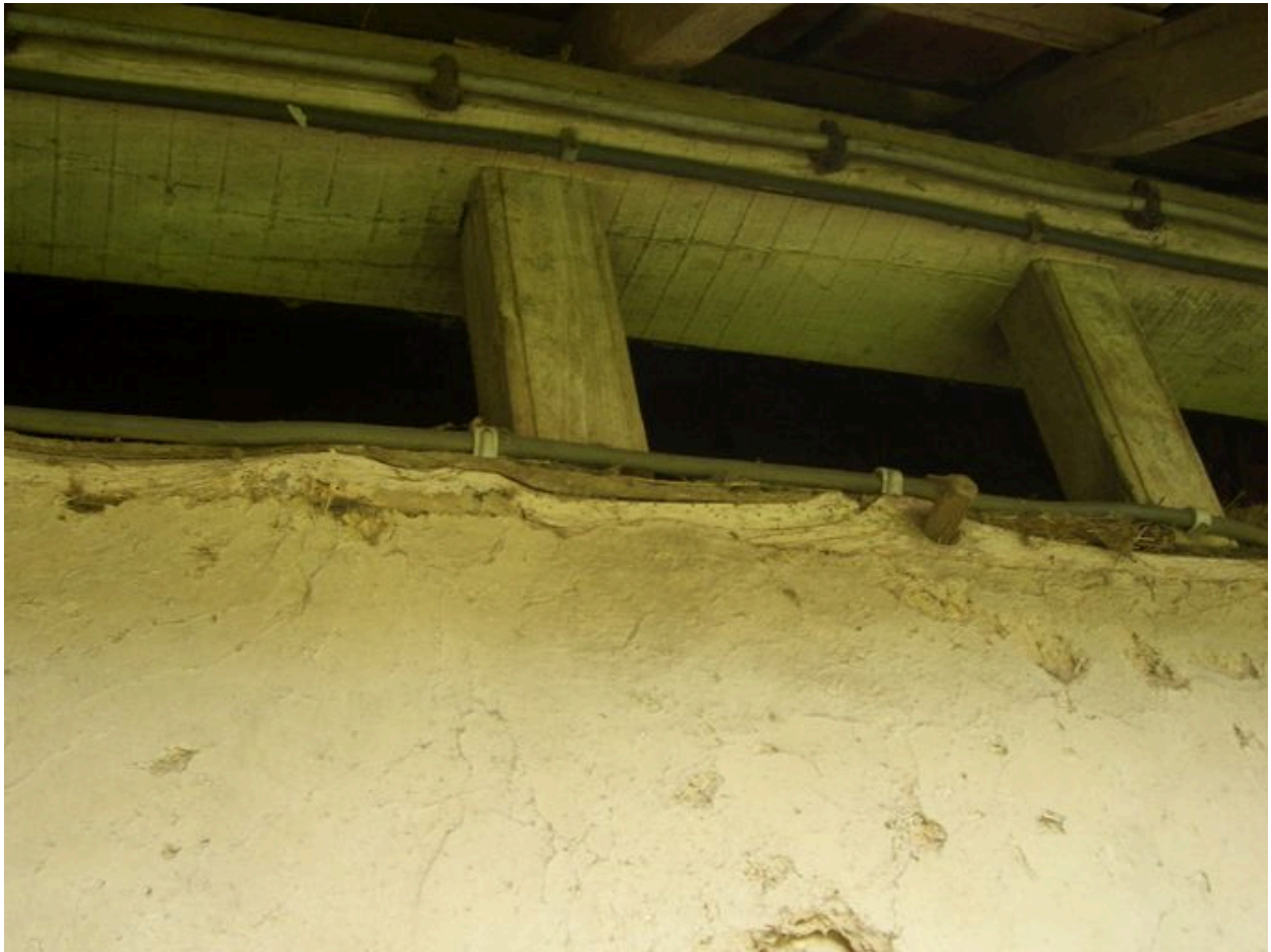
Détail du réhaussement en torchis et pans de bois.
