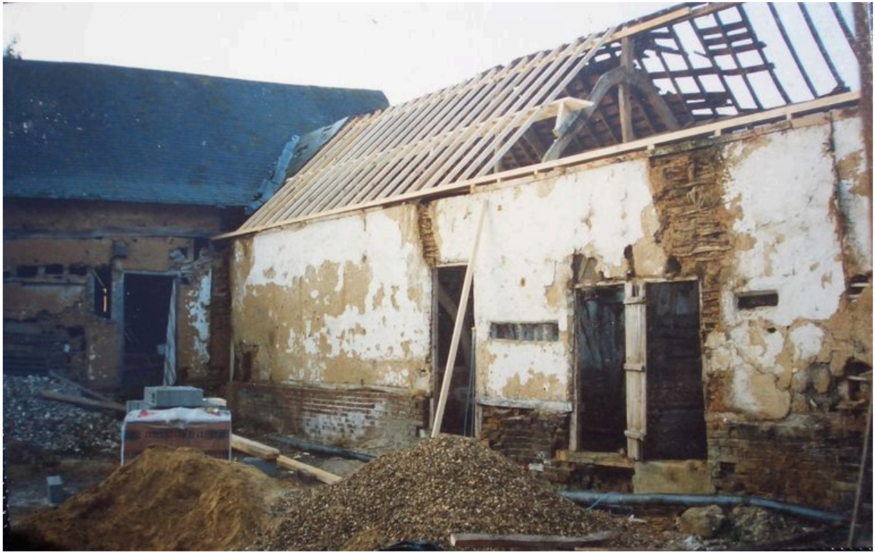
Vue des étables aujourd'hui entièrement reconstruites.
