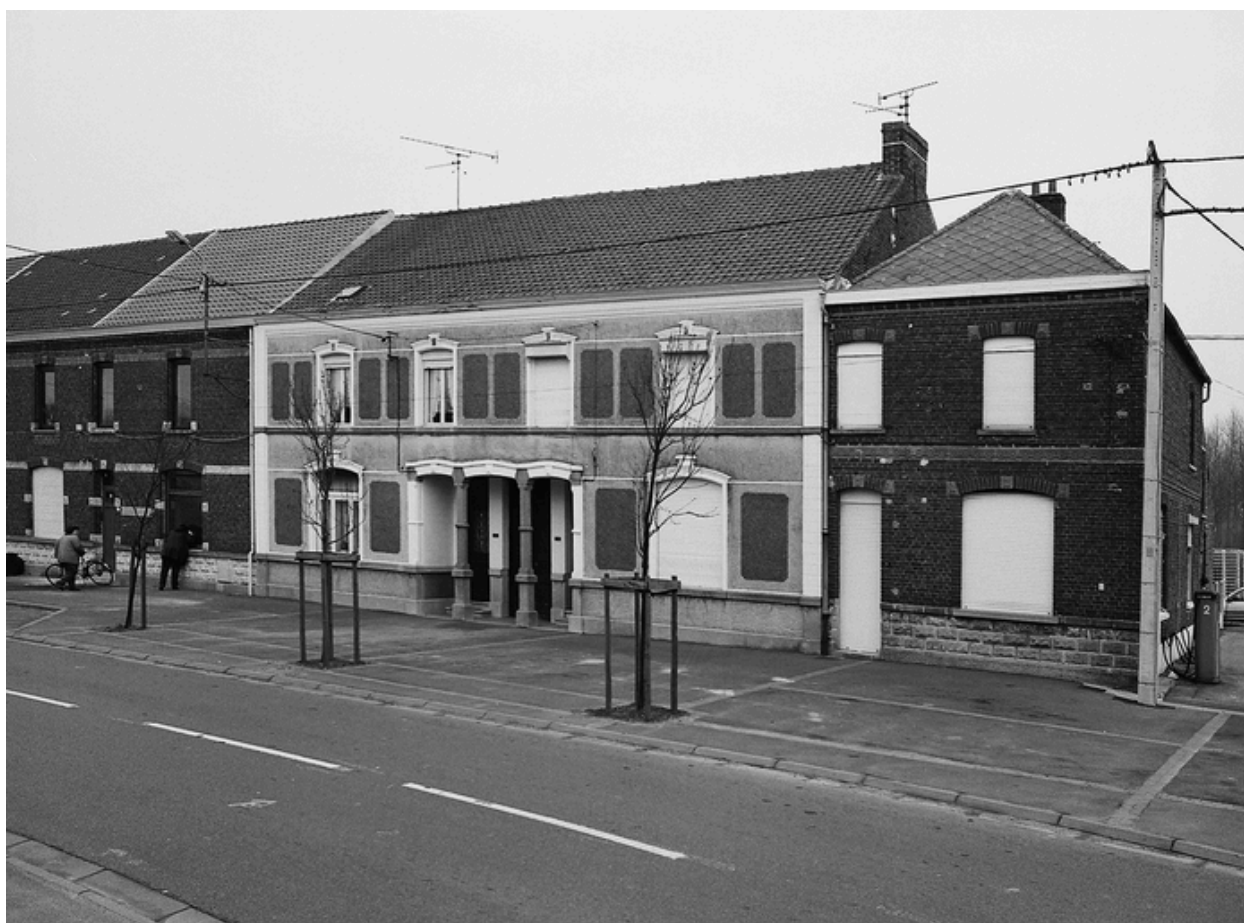
Maison, 40-32, rue du Pont.
