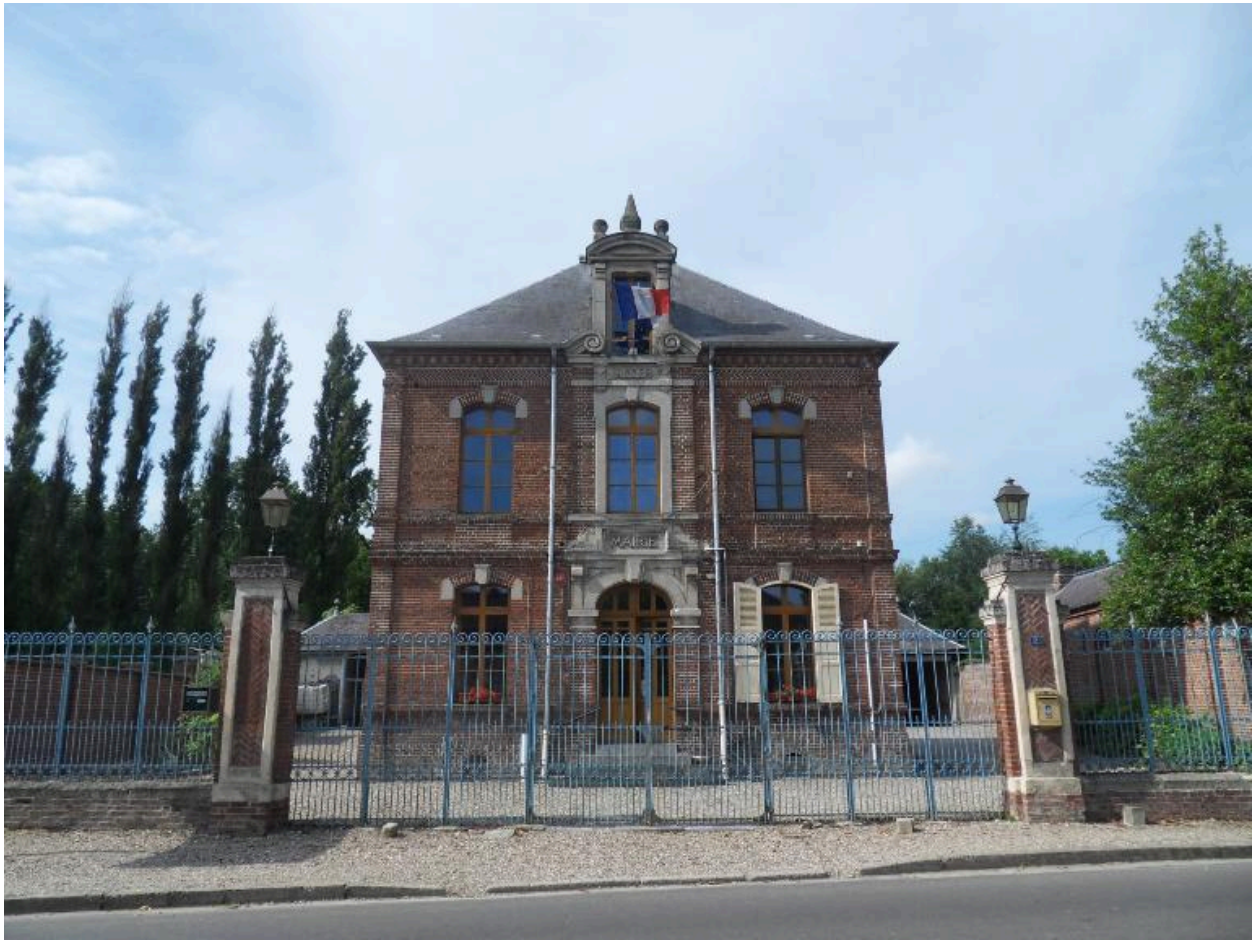
La mairie et l'ancien logement de l'instituteur.
