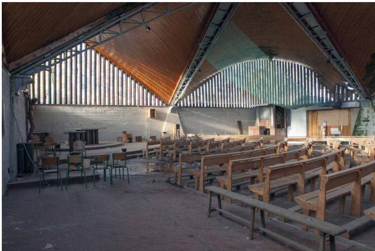
Vue générale vers le flanc sud.
