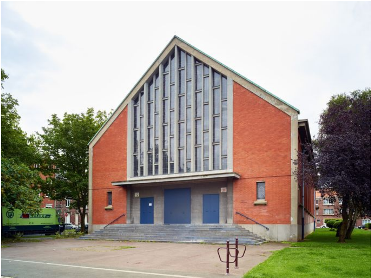
Élévation antérieure de l'église.
