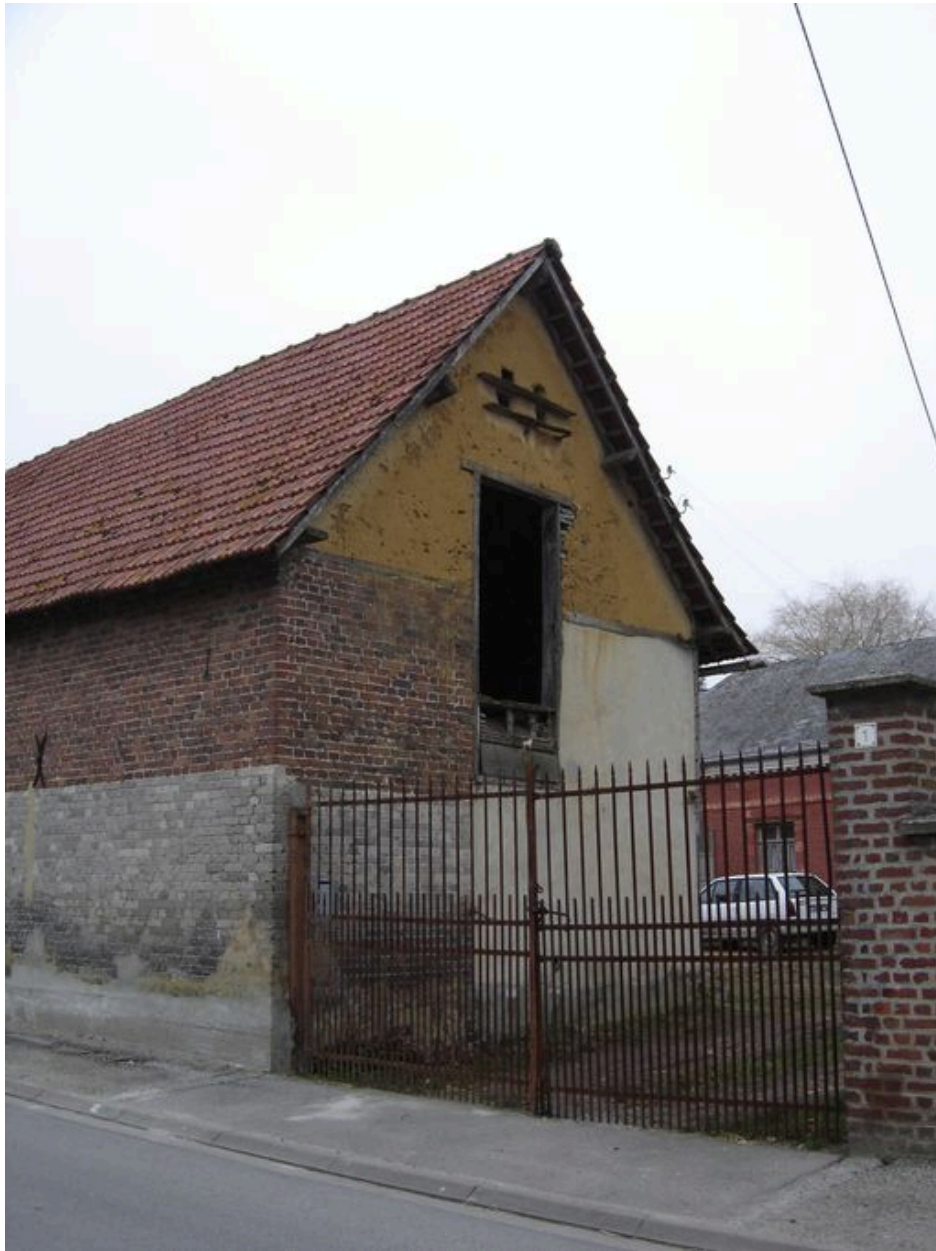
Vue partielle de la grange sur rue.
