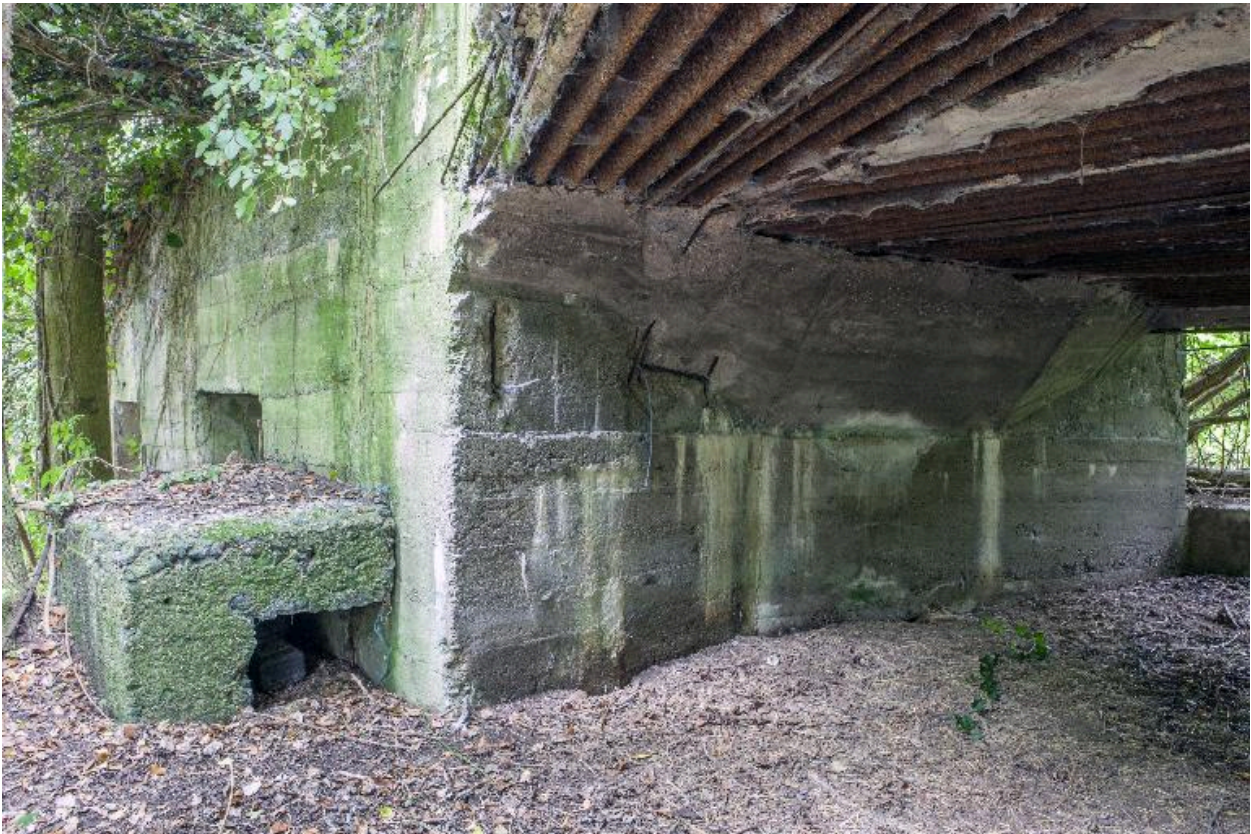
Profil sud de la chambre de tir
