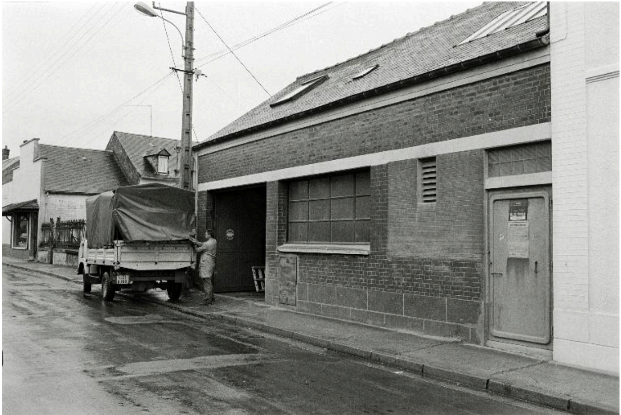
Atelier de fabrication, élévation antérieure, en 1990.
