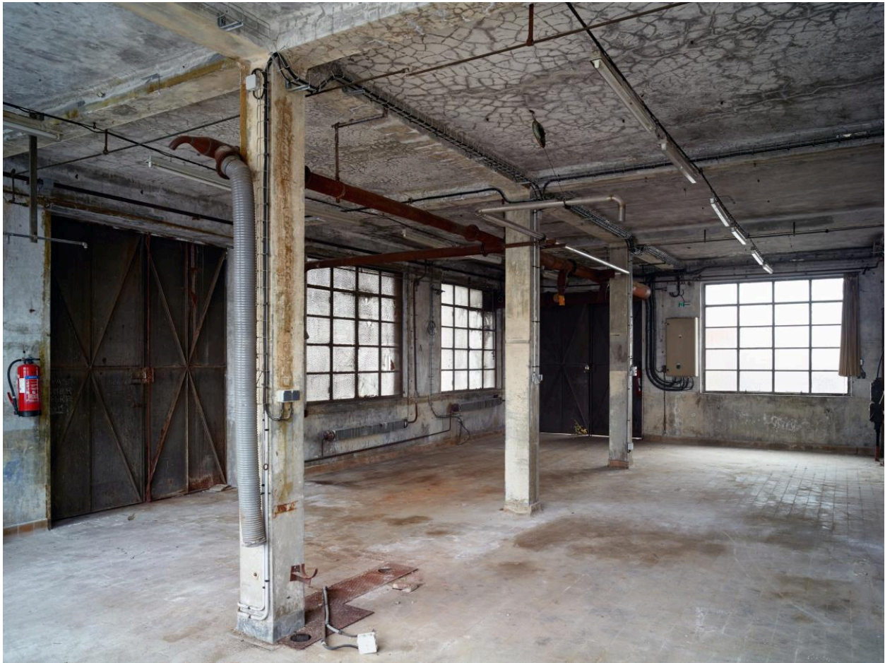
Vue intérieure de la menuiserie (I).
