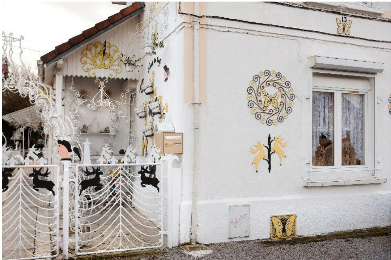
Vue générale sur rue.
