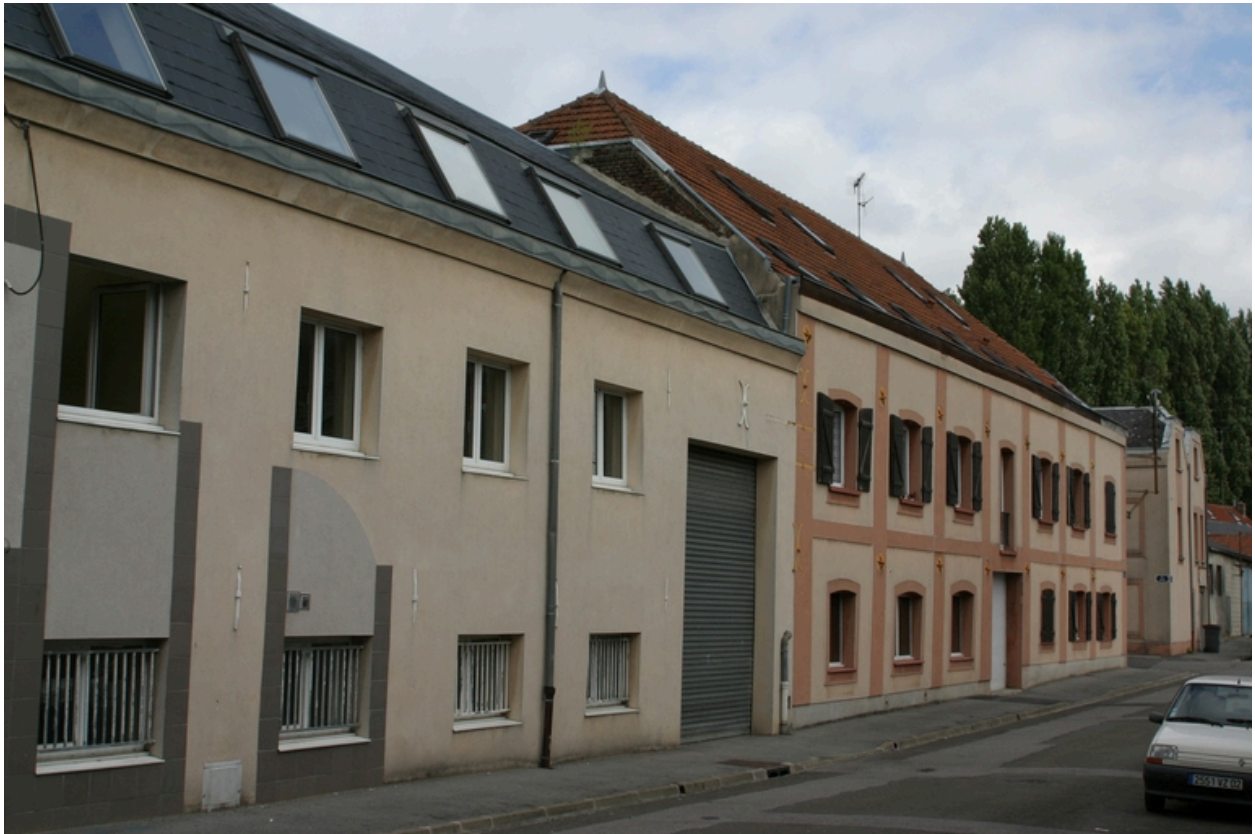
Façade antérieure des anciens ateliers et magasins, rue du Vivier.
