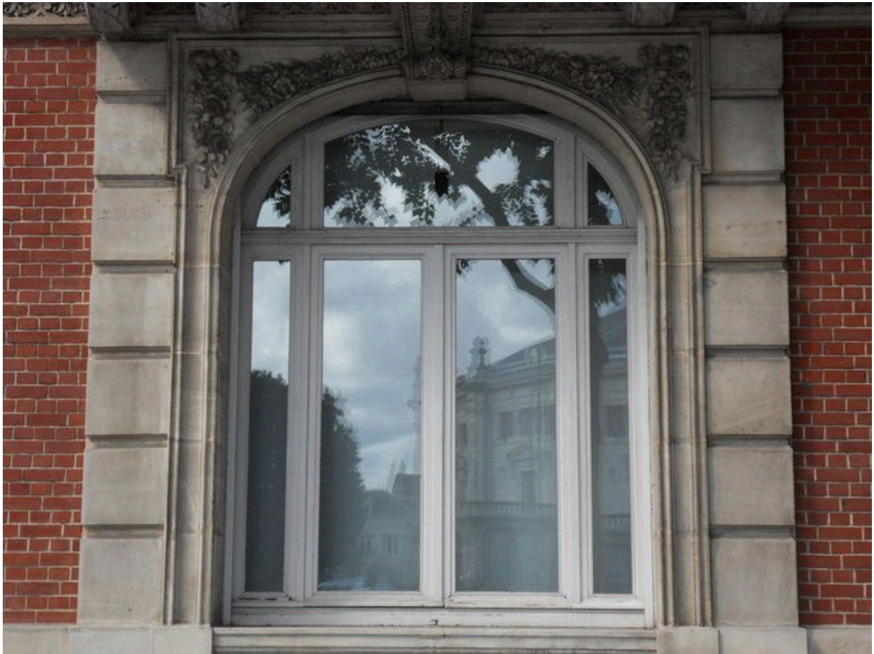
Vue de détail sur la fenêtre du petit salon.
