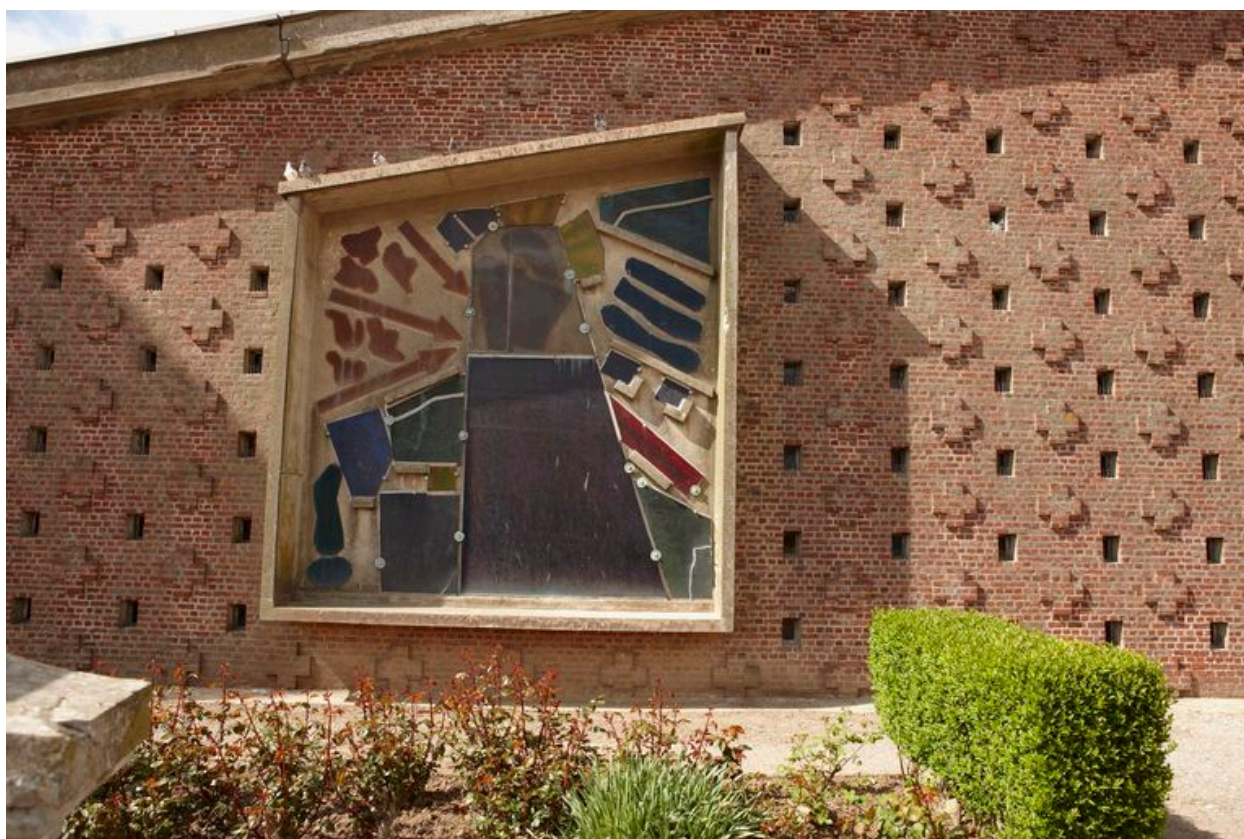
Vue extérieure d'une verrière.
