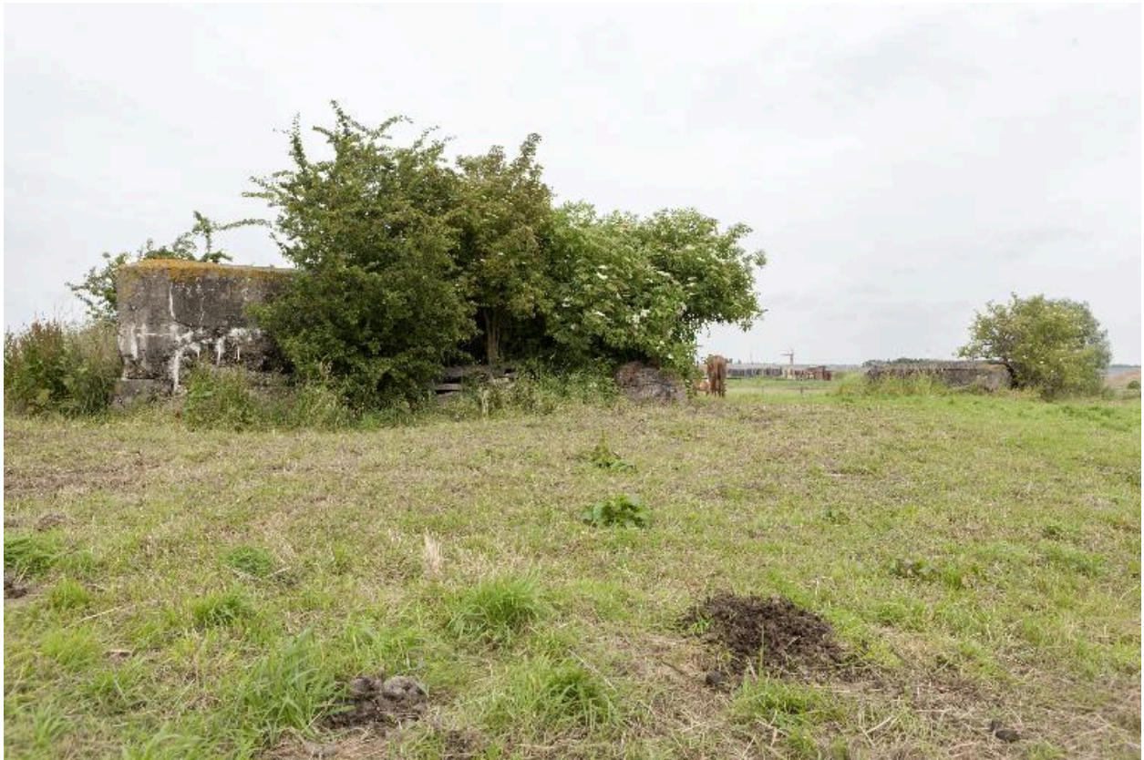
Casemates a, à gauche et b, vers le nord
