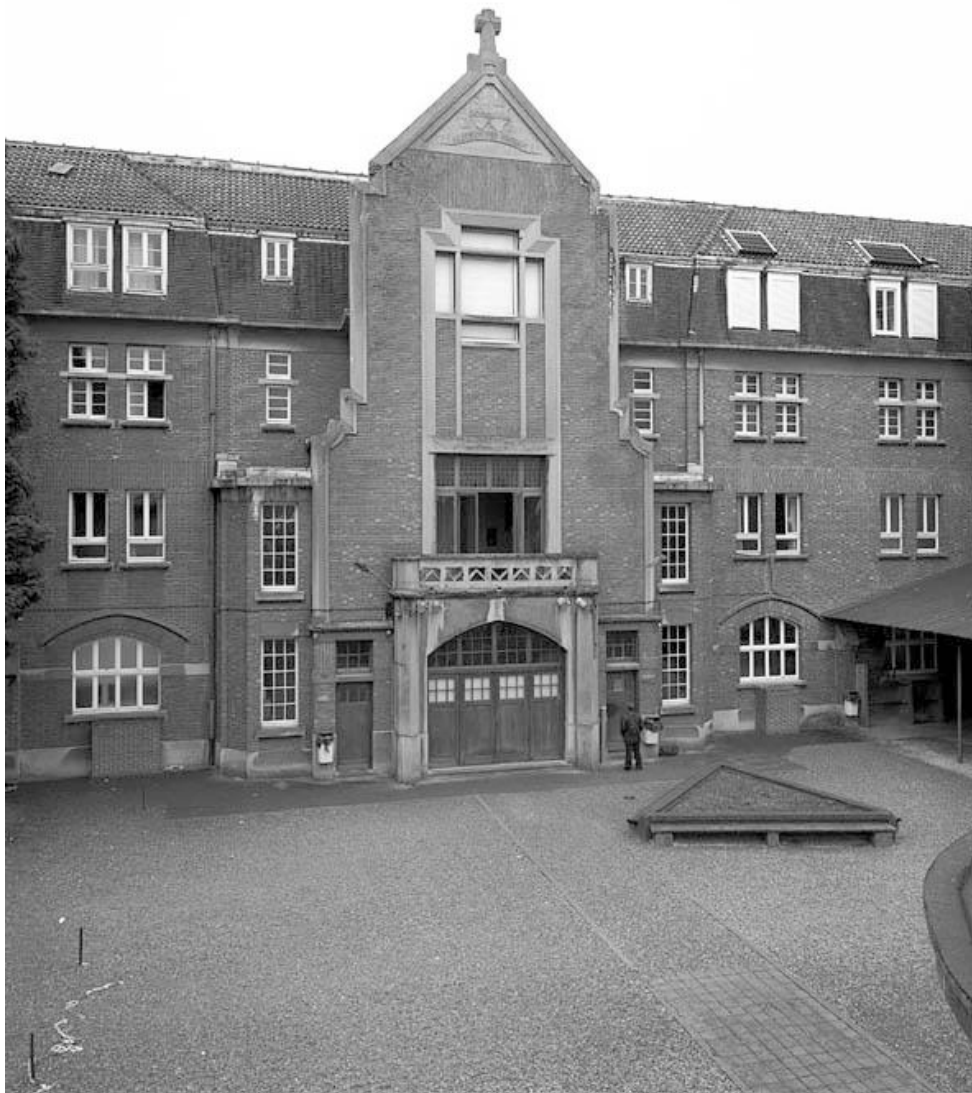
Élévation antérieure de la chapelle.
