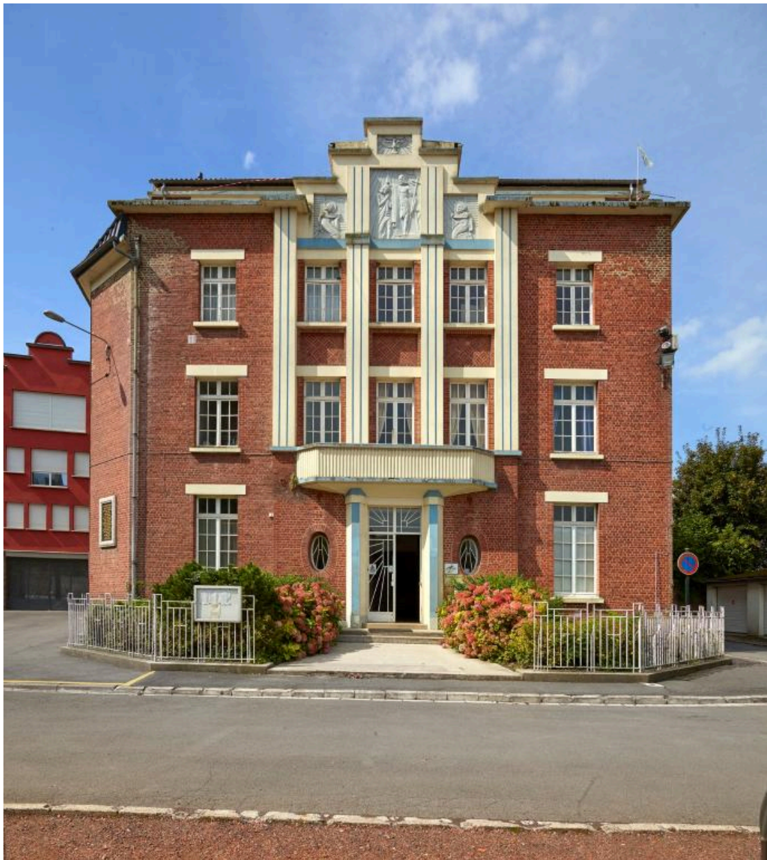
Collège Saint-Jean-Baptiste. Façade principale. Construit entre 1929 et 1931 par Paul Clavier.
