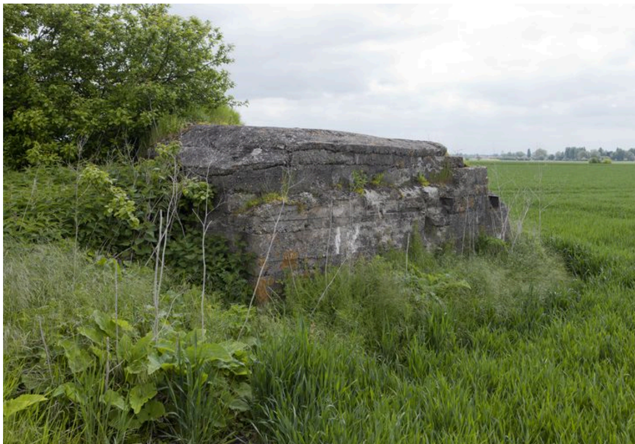
Vue latérale, vers le nord-est
