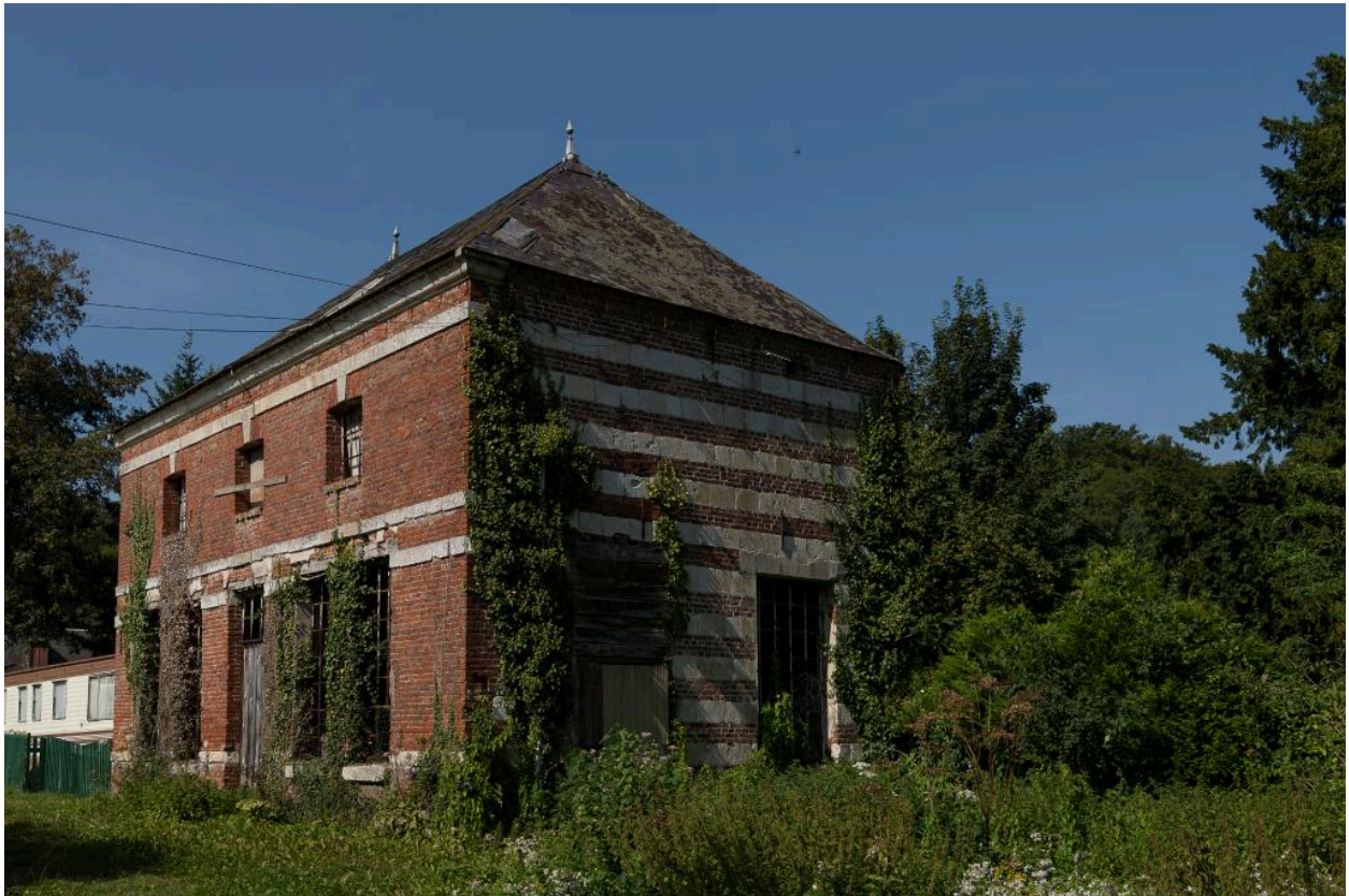
Orangerie vue depuis l'est.
