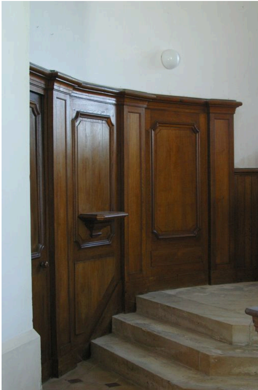
Vue des lambris de demi-revêtement du chœur.
