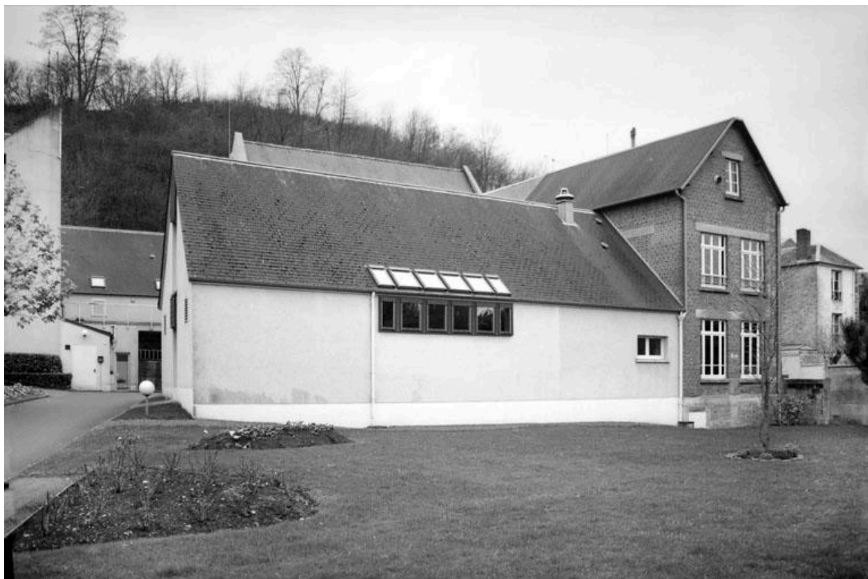
Vue des bâtiments, depuis l'arrière.
