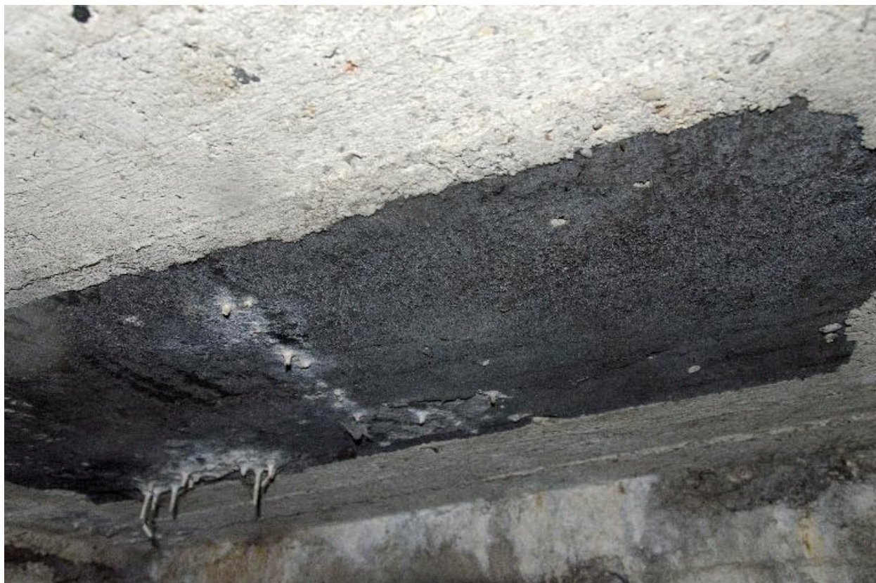
Salle S8, plaque métallique au plafond
