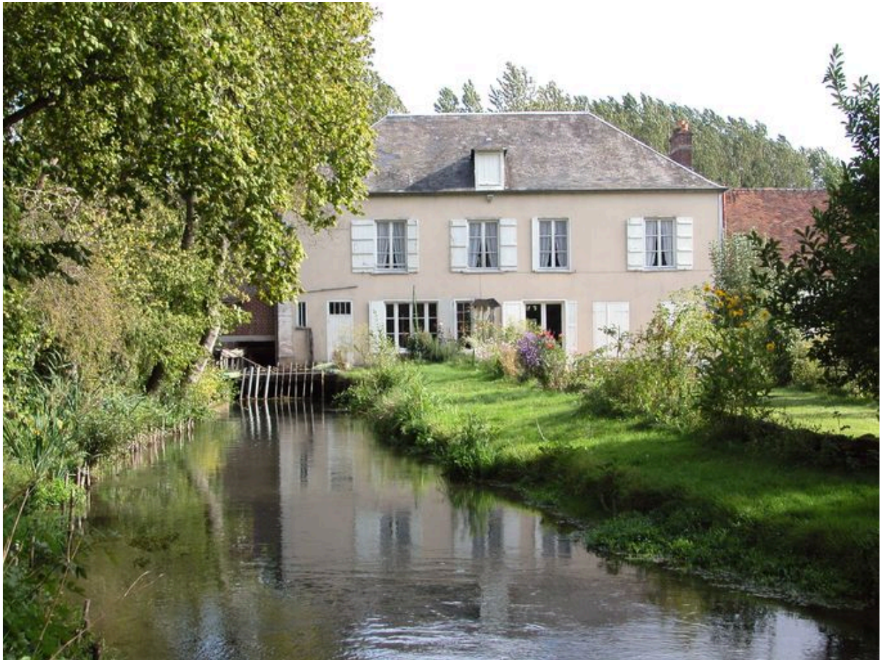
Vue d'ensemble du moulin et de la rivière, façade postérieure.
