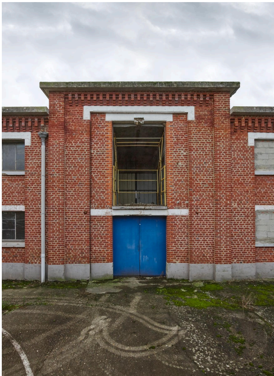
Entrée des entrepôts sur la façade est (bâtiment E).
